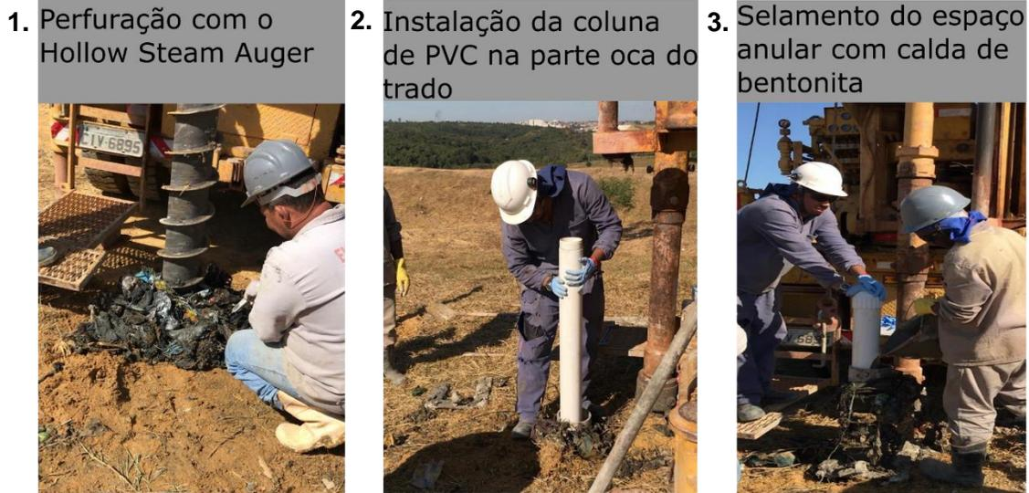
Figura 4.14: Passos para a instalação dos furos usando a perfuratriz oca "Hollow steam auger".
