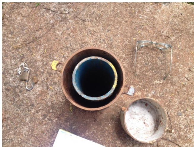
Figura 5.1 – Parte externa do poço, no qual foram realizadas as perfilagens geofísicas. Terminação em base de concreto com revestimento metálico nos primeiros 10 metros, protegendo o revestimento de PVC que continua ao longo do pacote sedimentar.
