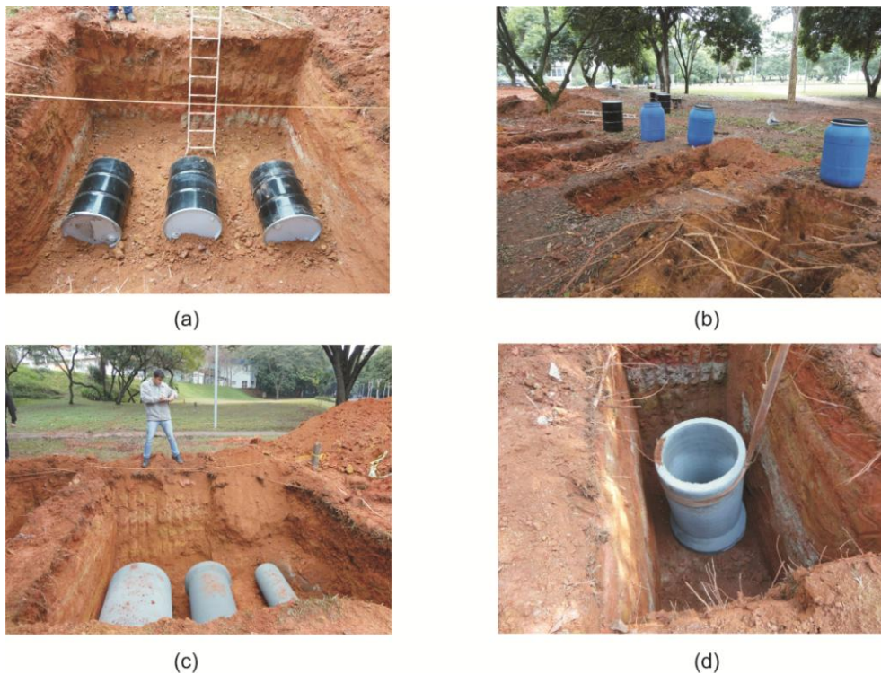
Figura 2.9. Alvos posicionados ao longo da Linha 1 do SCGR – II. (a) Tambores metálicos. (b) Tambores de PVC preenchidos com diferentes fluidos. (c) Manilhas de concreto horizontais. (d) Manilha de concreto vertical.
