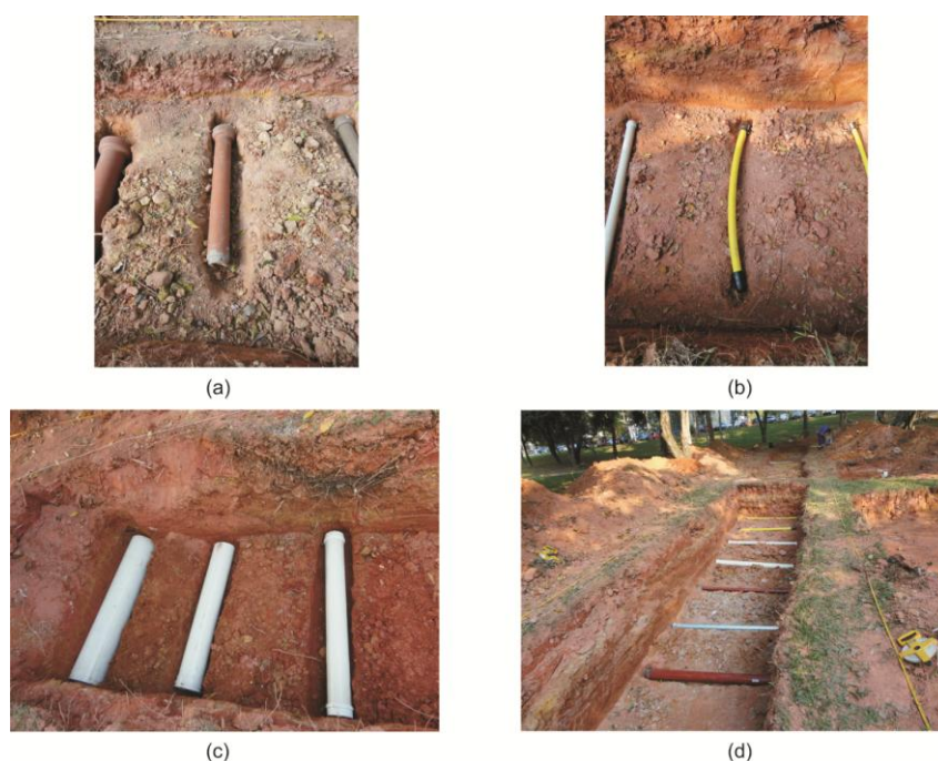
Figura 2.11. Alvos posicionados ao longo da Linha 3 do SCGR – II. (a) Manilha de cerâmica. (b) Tubo de polietileno. (c) Tubos de PVC. (d) Tubos metálicos, PVC e de polietileno.
