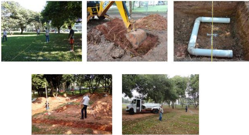
Figura 2.8. Principais etapas da construção do SCGR – II. Demarcação das valas, abertura dos buracos, colocação dos alvos, medida da profundidade dos alvos e recuperação da paisagem.
