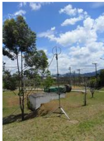
Figura 3.4. Sensor da rede LINET instalado na companhia de energia EDP em Mogi Mirim-SP. Fonte: Projeto CHUVA (2011).
