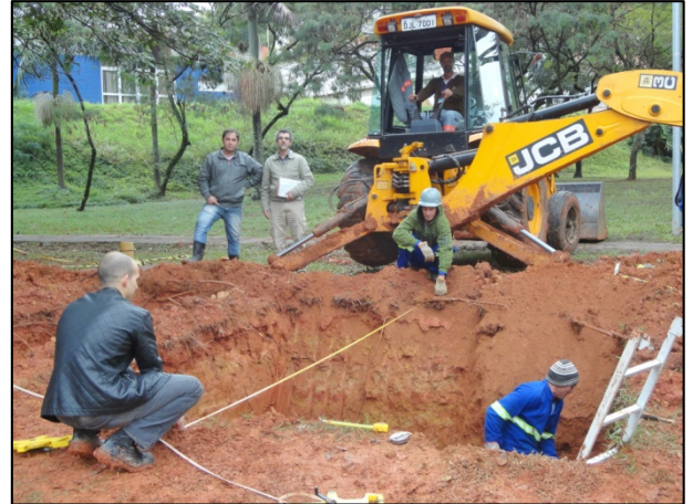
Figura 3.3. Retroescavadeira utilizada para a abertura das valas nas linhas 1, 2 e 3 do SCGR-II e aferição das medidas das valas.
